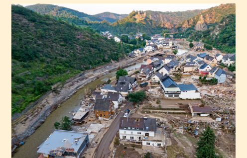
Am 14. und 15. Juli 2021 kam es aufgrund extrem starker Regenfälle im Ahrtal zu einer schweren Flutkatastrophe.
