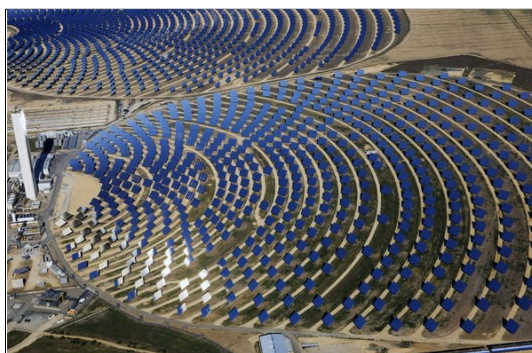
Solarthermisches Kraftwerk in Südspanien: Luftaufnahme des "PS10". Das Solarturm-Kraftwerk produziert mit 624 beweglichen Spiegeln und einer installierten Leistung von 11 Megawatt Strom für 10.000 Menschen. (Foto: ©Greenpeace / Markel Redondo)
