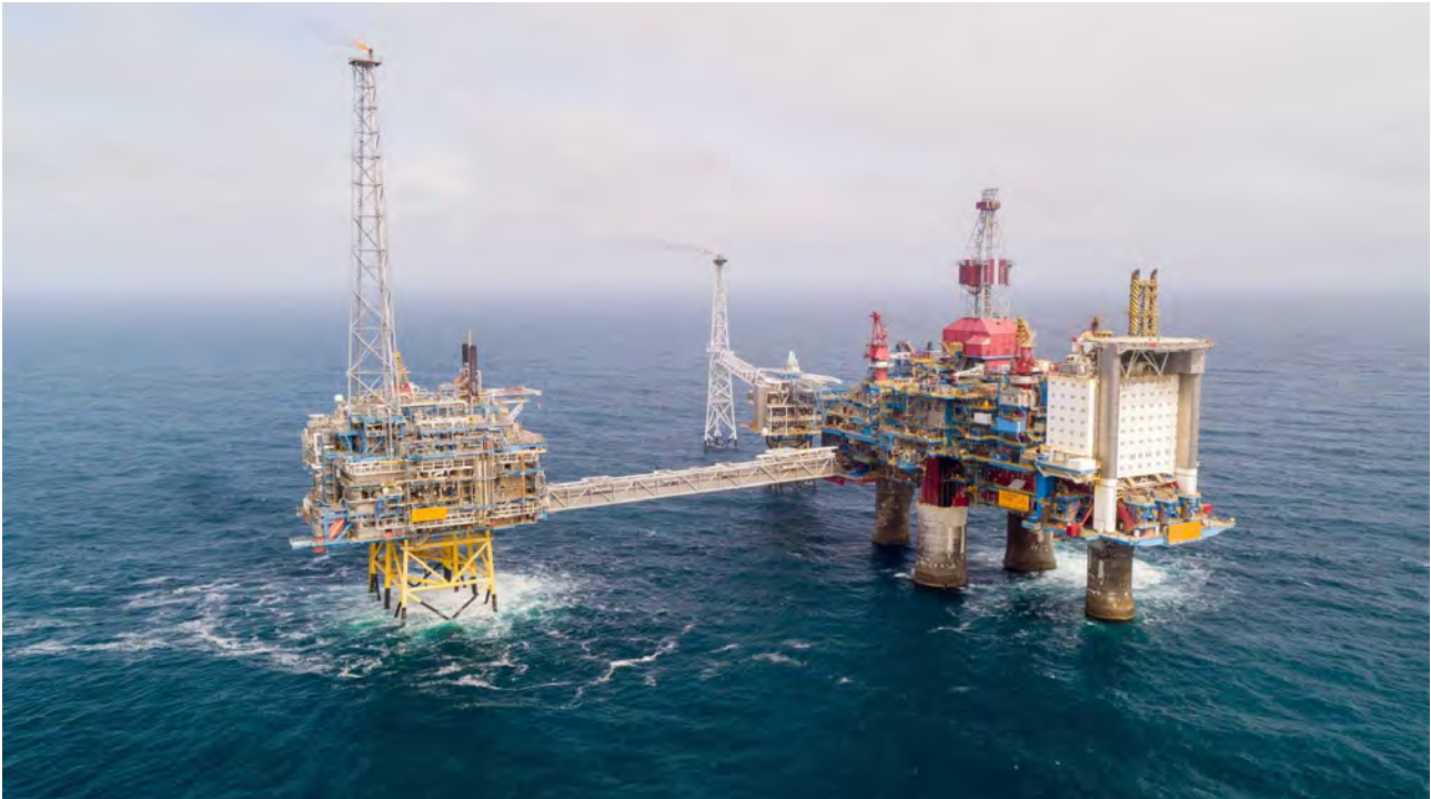
Abbildung 16 – Sleipner Ost Komplex. Rechts: Sleipner A Bohr- und Verarbeitungs-Plattform und Wohnquartier auf der Beton „Gravity Base“ Struktur. Links: Sleipner T Verarbeitungs-Plattform und CO 2 -Abscheidungsanlage (Amin-Prozess). Mitte: Sleipner R - Riser Plattform für Gas- und Kondensat Export und angebundene Fackel. Quelle: Equinor 2024b
