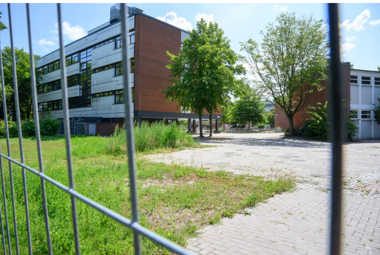
An der Wilhelm-Focke-Oberschule musste 2024 ein Gebäudekomplex wegen schwerer Tragwerksschäden gesperrt werden.
