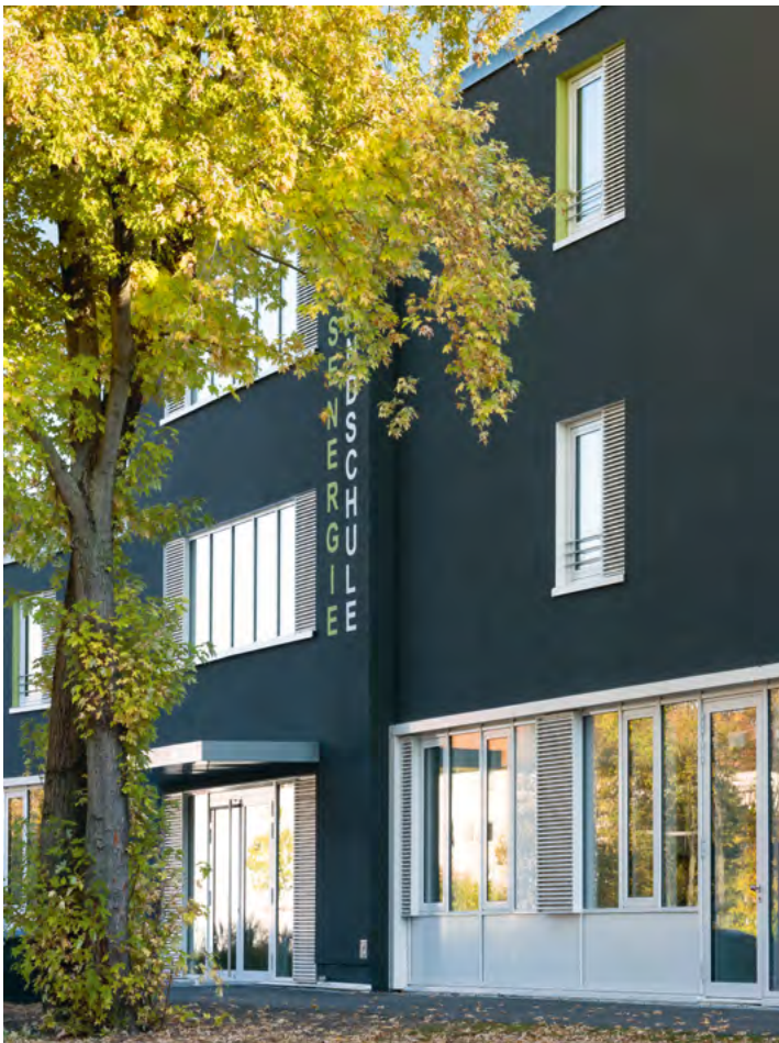
Beispiel: Klimapositives Schulgebäude der Uhlandschule
