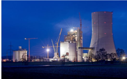
Abbildung 1: Baustelle E.ON-Kohlekraftwerk "Datteln 4"
